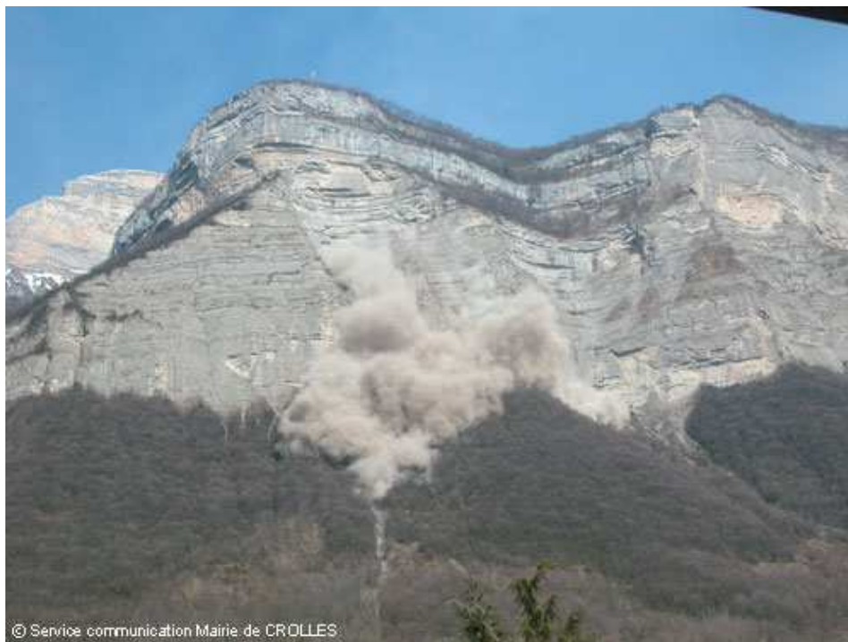
Chutes de pierres et de blocs depuis la falaise du Bec Margain, mars 2005. Les blocs se sont dispersés dans le massif forestier sans atteindre les habitations ni les ouvrages pare-blocs [IRMA]
