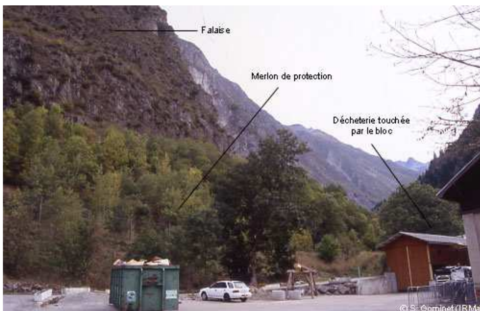
Venosc - Chute d'un bloc sur la déchetterie et les locaux des services techniques, septembre 2004. Le bloc a endommagé le toit de la déchetterie avant de heurter un mur des bâtiments des services techniques. Il est passé par dessus le merlon de protection construit quelques années auparavant [IRMA]
