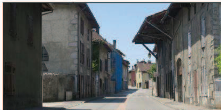
L'aménagement prévoit la mise en place d'un feu en alternat de chaque côté de la portion de la RD où la voie est la plus étroite (la largeur est inférieure à 6,50 m). Signalisation, marquage au sol, végétation, revêtements : le chantier devrait occuper ce second semestre.
